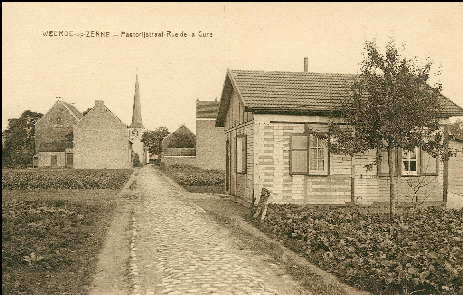
Noodwoningen opgetrokken in de Pastorijstraat van Weerde
