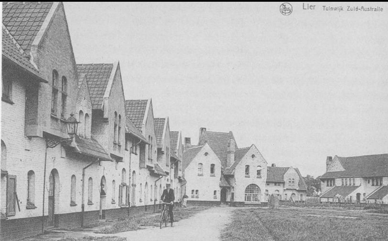
Lier , tuinwijk "Australie" , arch. Flor Van Reeth 1920 , Nationale maatschappij goedkope woningen (1919) Vernield tijdens WO II
